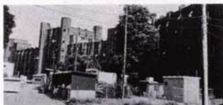
電柱及びキュービクルの撤去前
