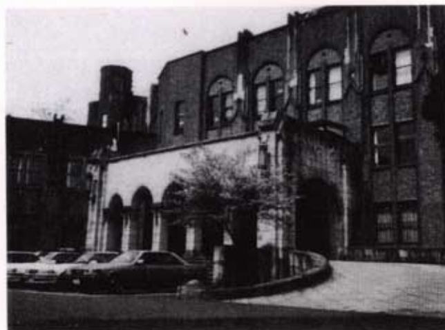
サイクロトン棟（廃止）の改修工事も始まります。
